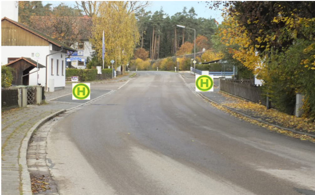
Bild 19: Links und rechts sind die Buchten der Haltestellen zu erkennen (Blickrichtung Nürnberg)
