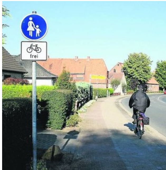
Bild 27: Gehweg mit Zulassung des Radverkehrs
