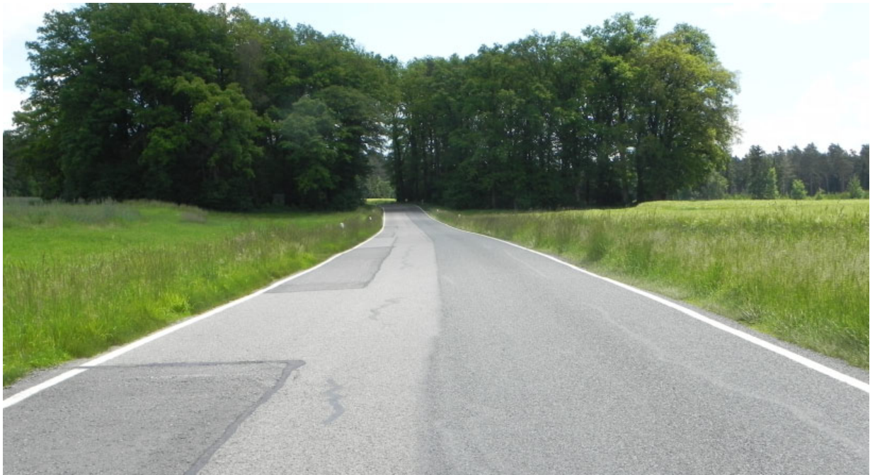
Bild 15: Südlicher Ortsausgang Blickrichtung Süden (Allersberg)
