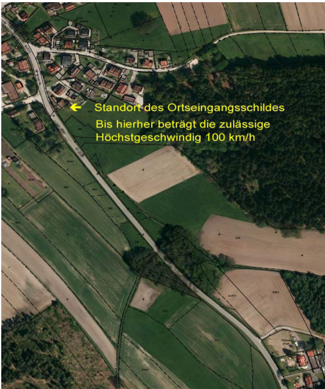
Bild 14: Südlicher Bereich der Staatsstraße.
