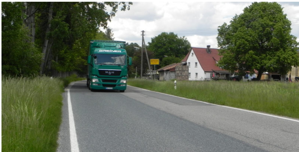
Bild 16: Staatsstraße im südlichen Bereich
