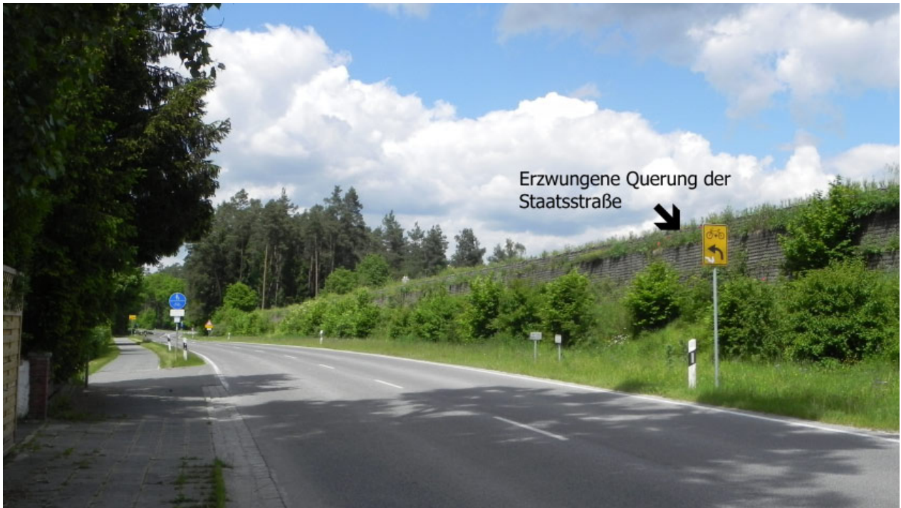
Bild 4: Nördlicher Ortseingang Sperberslohe mit Blickrichtung Norden (Nürnberg) Das Bild zeigt zusätzlich die erzwungene Querung der Staatsstraße für den Radverkehr.
