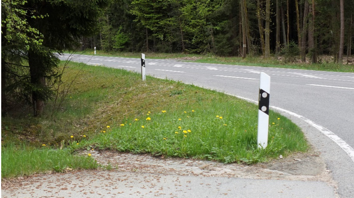
Abbildung 3 Die Sicht für Fußgänger und Radfahrer ist stark eingeschränkt. Sich nähernder Verkehr ist erst sehr spät sichtbar.
