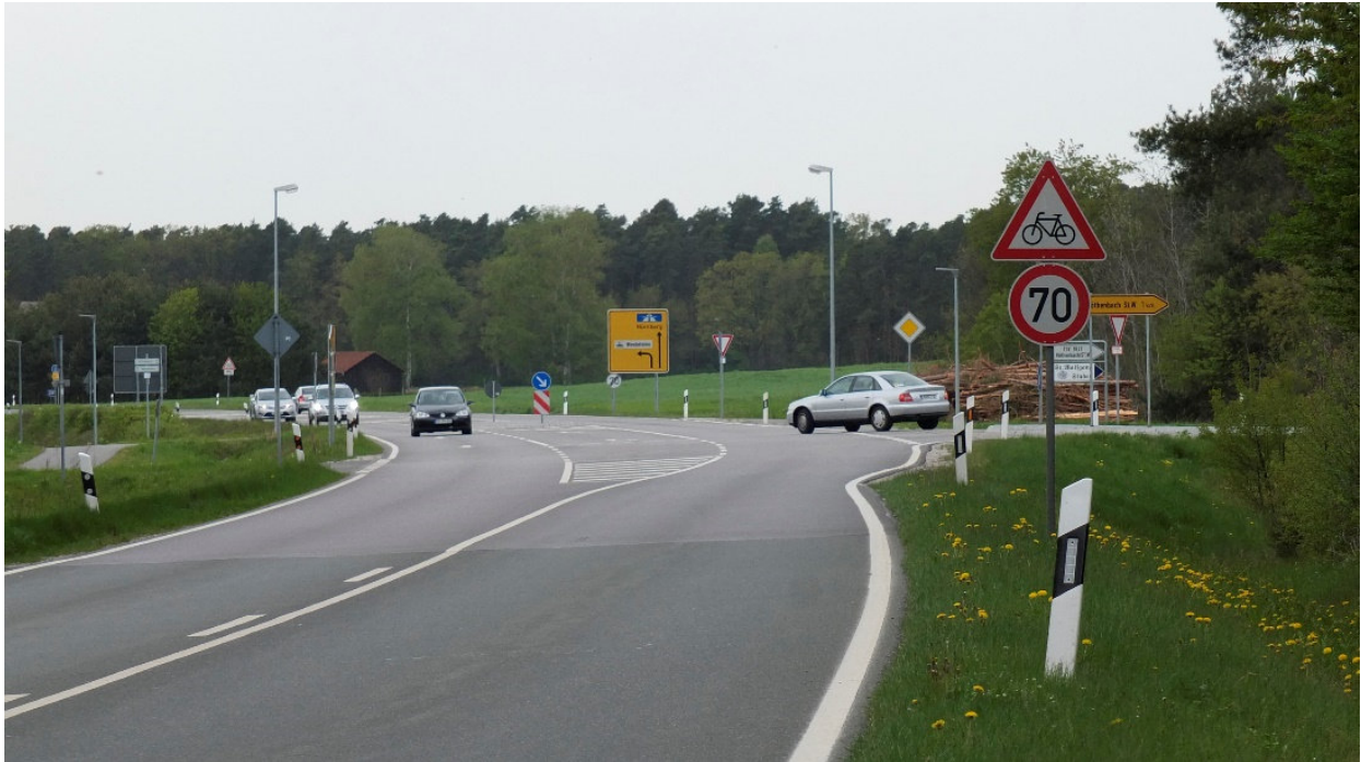
Abbildung 14 Die Kreuzung Richtung Röthenbach ist durch Geschwindigkeitsreduzierung und durch Querungshilfe gesichert. Beides ist an der vergleichbaren Kreuzung Richtung Pyrbaum nicht vorhanden
