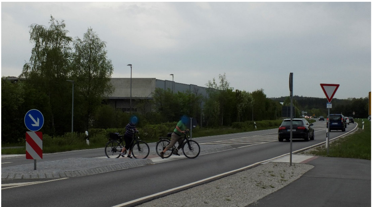
Abbildung 15 Neben der Geschwindigkeitsreduzierung sichert die Verkehrsinsel zusätzlich die Querung des Rad- und Fußgängerverkehrs
