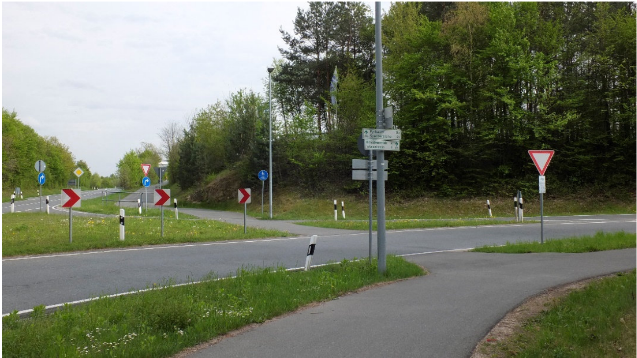
Abbildung 9 Zusätzlich wird der Radverkehr bei Wendelstein gewarnt und es existiert eine Querungshilfe
