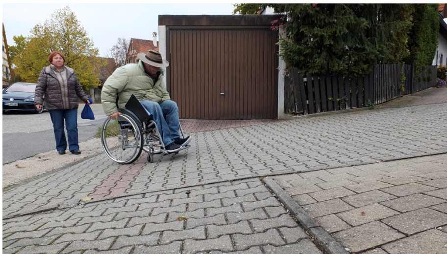
Abbildung 4 Zu großes Längsgefälle
