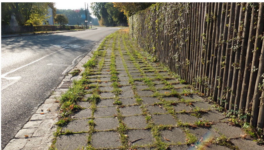
Abbildung 8 Unebener Belag über die gesamte Länge des Fußweges
