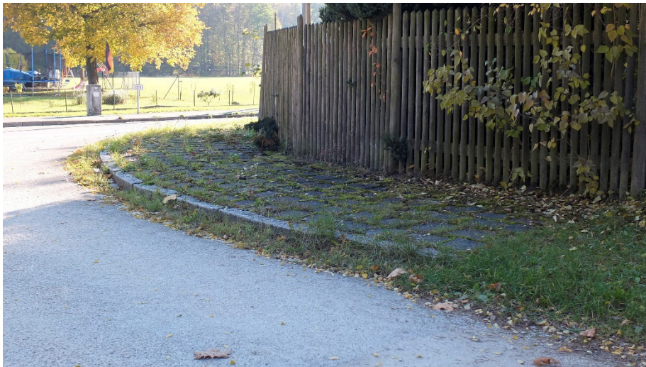
Abbildung 7 Gleiche Stelle: Hoher Bordstein, Gehweg nicht nutzbar
