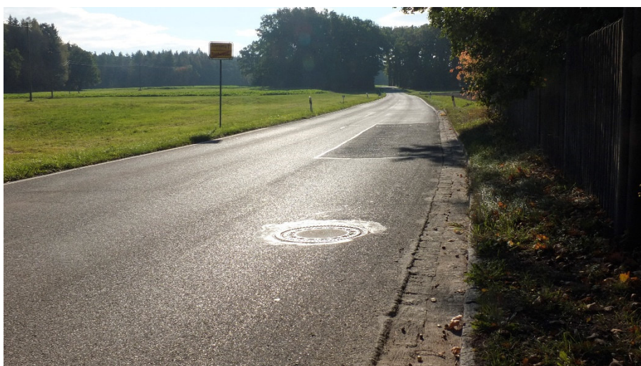
Abbildung 5 Fehlender Fußweg zu den Häusern Allersberger Str. 22 und 24
