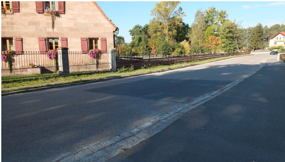
Abbildung 10 Im südlichen Bereich von Sperberslohe fehlt ebenfalls ein Fußgängerüberweg
