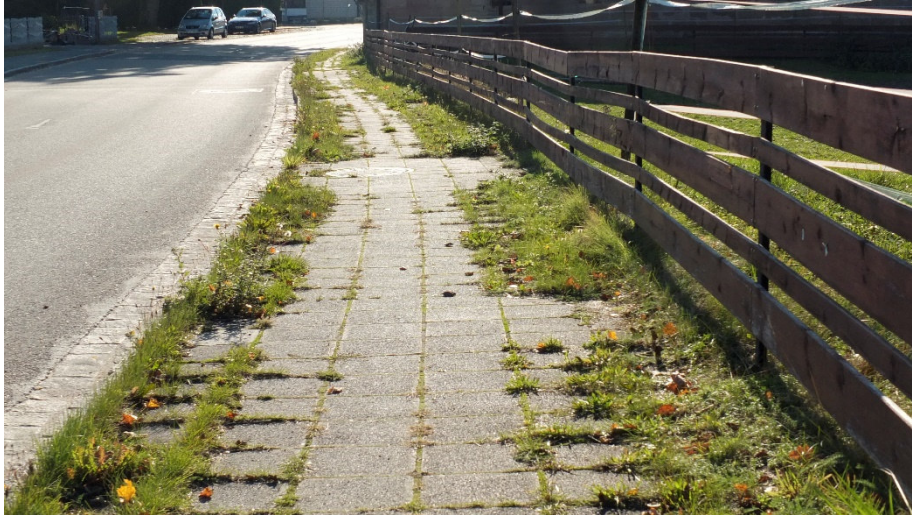
Abbildung 15 Starker Bewuchs zwischen den Gehwegplatten
