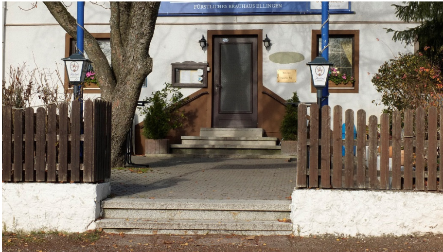
Abbildung 3 Stufen ohne Rampen im Eingangsbereich
