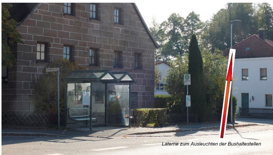
Abbildung 5 Beleuchtung der Bushaltestelle
