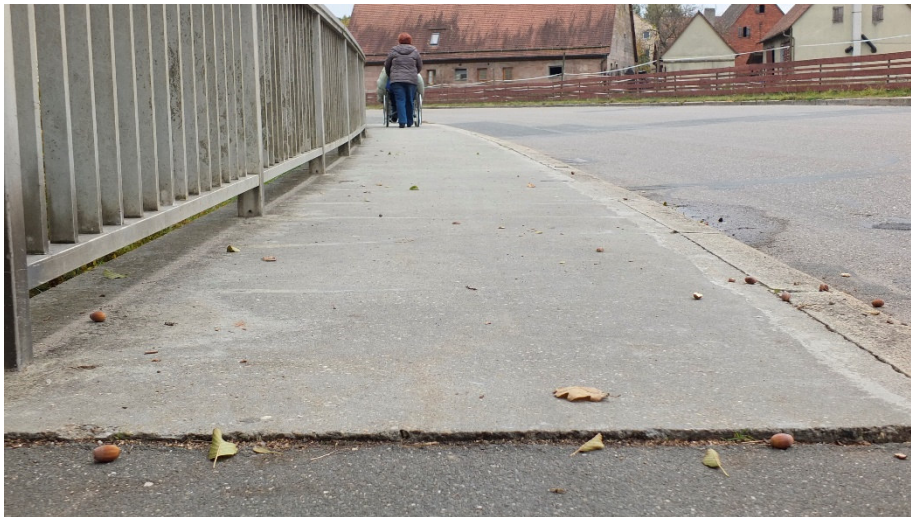
Abbildung 19 Stolperfallen an den Brückenseiten
