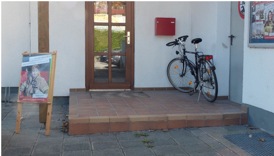
Abbildung 1 Treppenstufe ohne Rampe im Eingangsbereich
