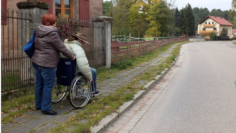
Abbildung 9 Starker Bewuchs zwischen den Gehwegplatten
